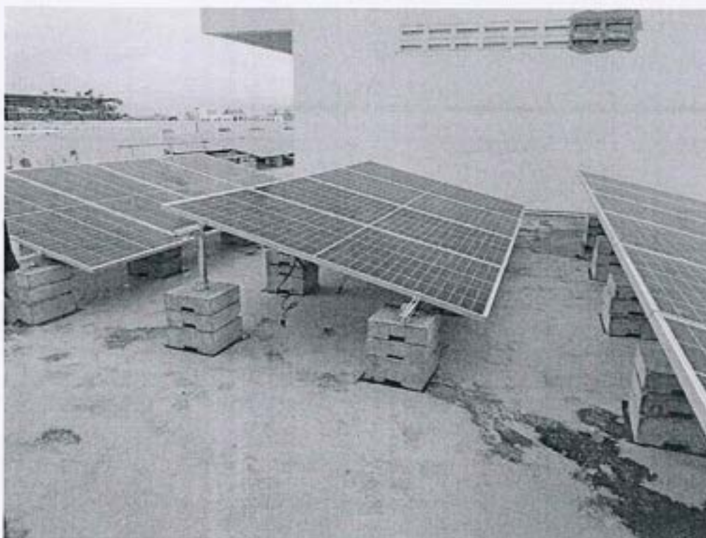
ตัวอย่าง การติดตั้งอุปกรณ์พลังงานแสงอาทิตย์บนพื้น ค.ส.ล.
