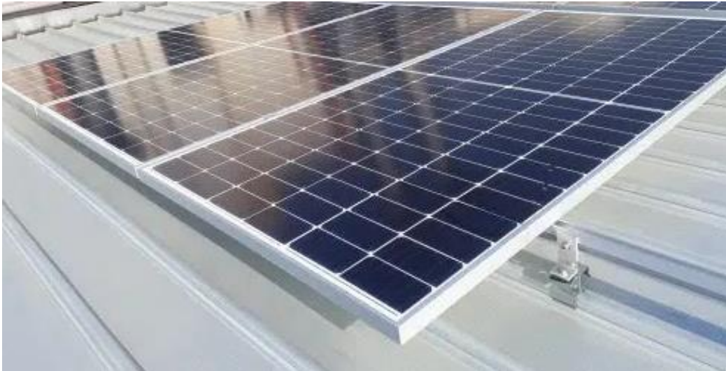
ตัวอย่าง การติดตั้งอุปกรณ์พลังงานแสงอาทิตย์บนหลังคาเมทัลชีท
